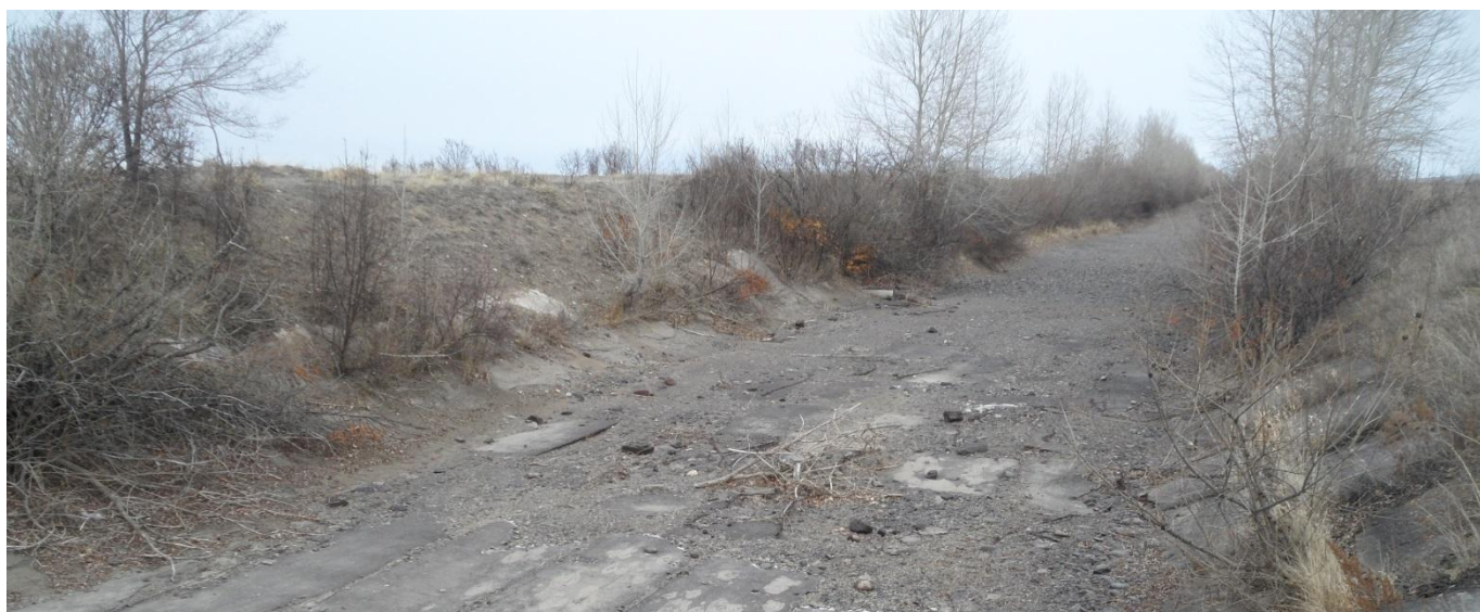
Фото 21 – Койбальский магистральный канал осенью, после осушения
