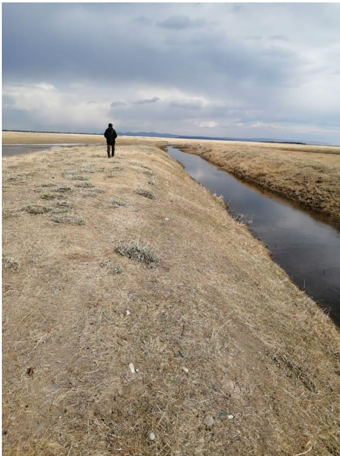
Фото 19 – Койбальский магистральный канал
